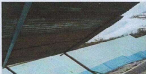
FOTO1: Remplazo de estructura metálica con tubo de 2x4 y tubo de 3x3, Con distribución de un metro en modulo 1
