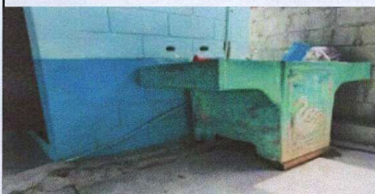
FOTO3: Remozamiento de tubería de drenaje y agua potable para pila
