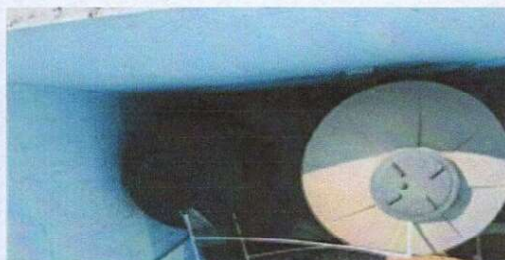
FOTO2: Refuerzo a columnas existentes que sostienen los depositos de agua 1 de 1000 ml y otro de 2500ml
